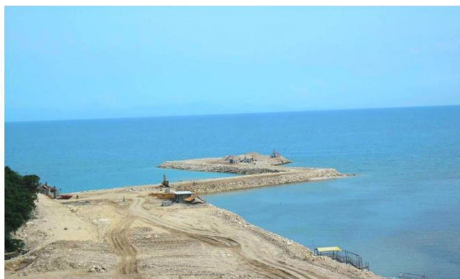
On-going jetty construction for the Philippines LNG Hub
