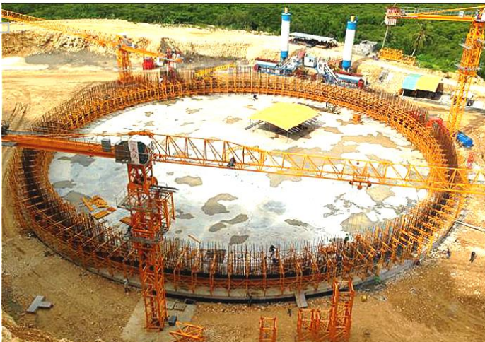
Pagbilao LNG Hub site, the Philippines
